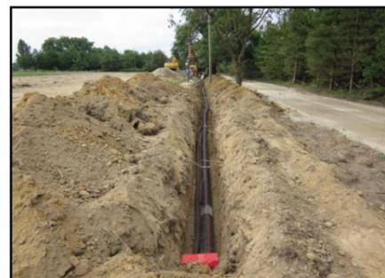
Réalisation des tranchées et pose des câbles
