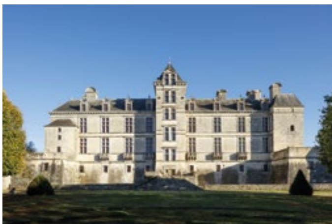
Château des ducs d'Épernon, façade sur jardin © Éric Sander / Centre des monuments nationaux
