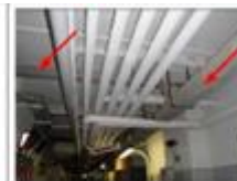
Conduites à câbles en fibrociment
