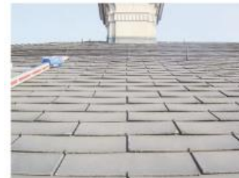
Plaques de toiture en fibrociment Plaques de toiture, panneaux de façade, etc.
