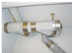
Conduites en fibrociment Les conduites sont souvent enduites de peinture ou de bitume
