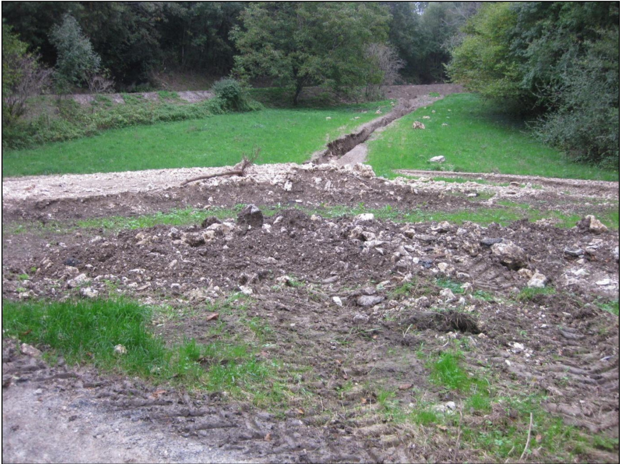
Figure 27 : Tranchée et cône de déjections suite à une crue torrentielle le long de la route menant au lieu-dit Le Mas [Source : IMS RN ]
