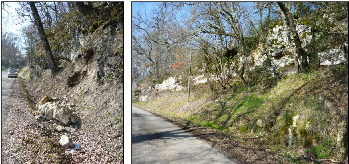
Figure 21 : Chutes de blocs le long de la RD 82, au niveau de la Celletie (à gauche) et talus rocheux le long de la route entre Bousouns et Saint-Julien [Source : IMS RN ]
