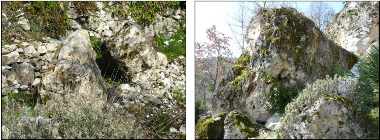
Figure 18 : Blocs de tailles variables au pied de l'escarpement [Source : IMS RN ]
