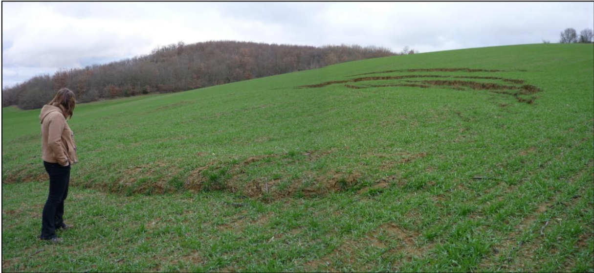
Figure 25 : Glissement superficiel à la Ritonne, sur la commune de Castelsagrat [Source : IMS RN ]
