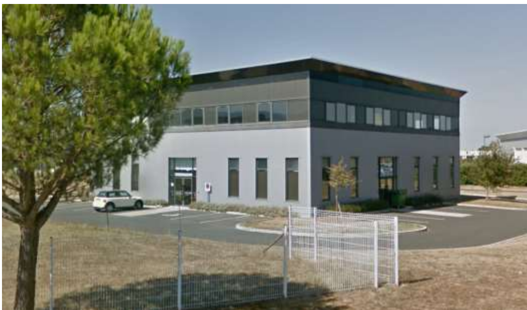
Figure 26 - Exemple de construction présentant une sobriété et une simplicité dans le traitement de l'enveloppe bâti
