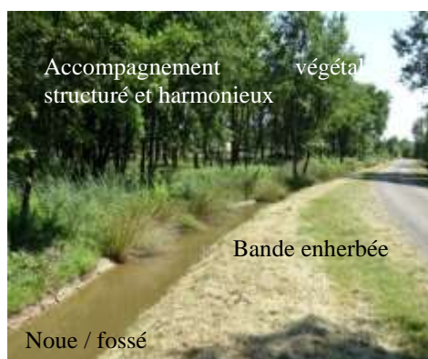
Figure 7 - Exemple d'aménagement conciliant trame végétale et gestion du pluvial (ZAC Grand Sud Logistique)
