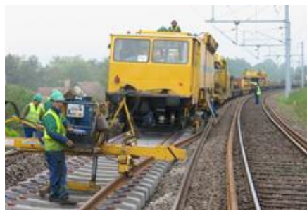
Longs Rails soudés sur traverses béton
