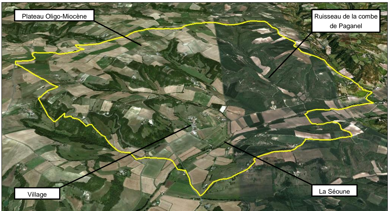
Figure 3 : Vue aérienne de la zone d'étude (relief exagéré) [Source : Google Earth / IMS RN ]
