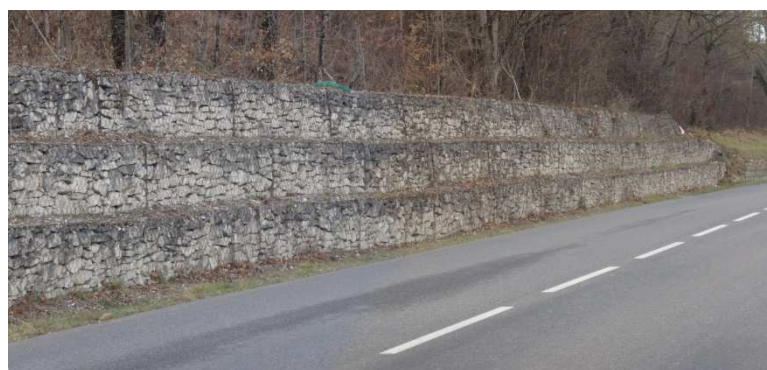
Figure 20 : Lieu dit « Serre Sèque » Ancien grand glissement stabilisé par des gabions
