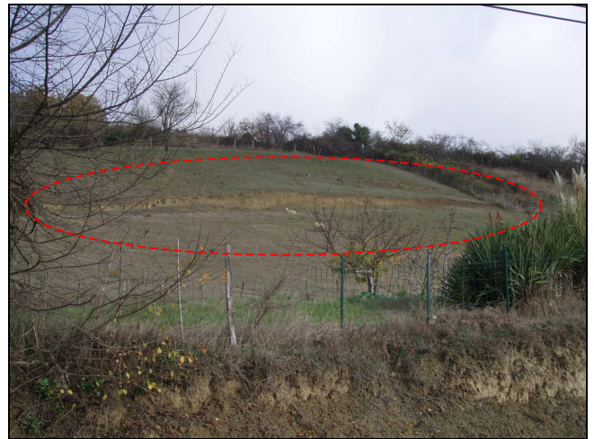
Lieu dit « Labade » Glissement supposé
