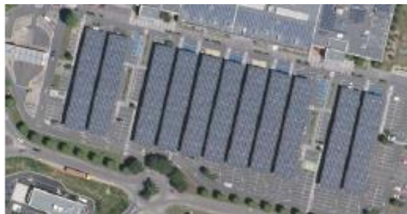
Centrale en ombrière du Géant Casino de Montauban (82)
