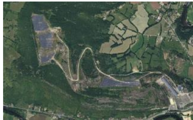
Centrale photovoltaïque de Varen (82)
