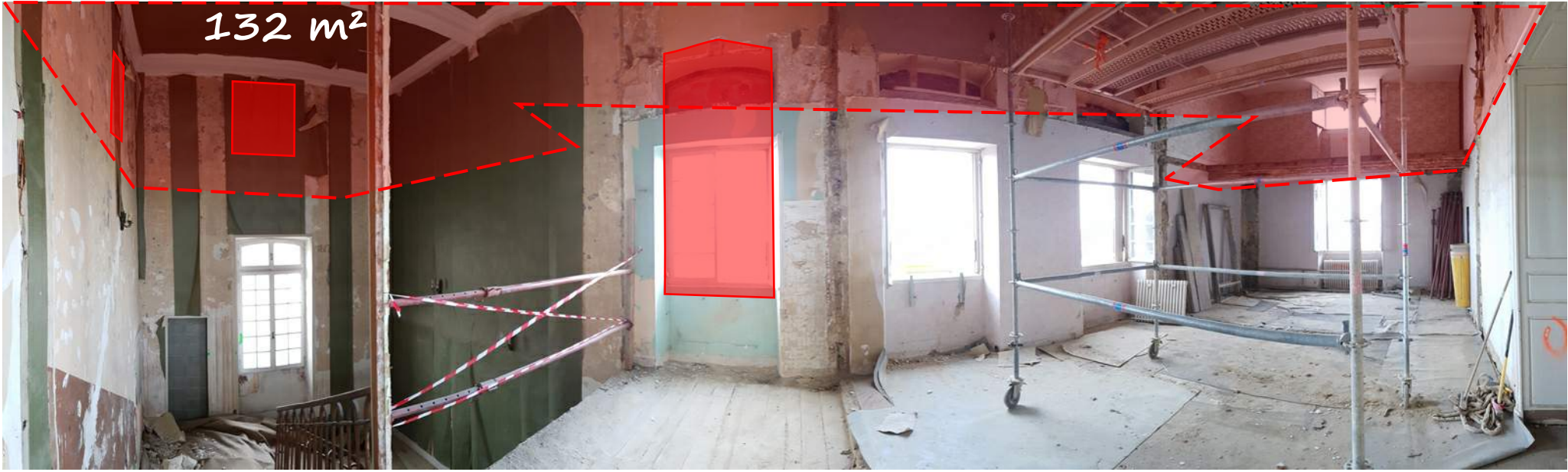
Ouverture des impostes de fenêtre et création d'une mezzanine en R+2 sur 92 m 2
