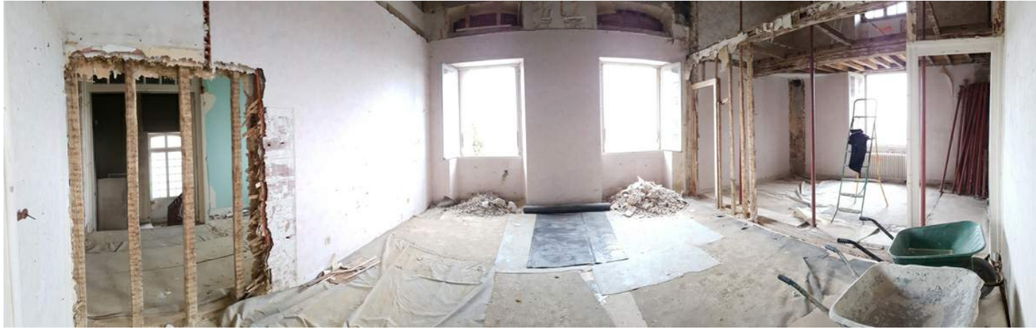
Ouverture des impostes de fenêtre et création d'une mezzanine en R+2 sur 92 m 2
