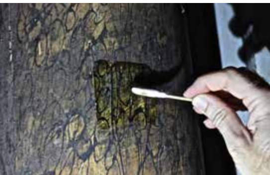
Haute-Garonne - Toulouse - Essai de nettoyage - Peinture faux marbre sur colonne en bois ©Atelier Rachez & Moreau
